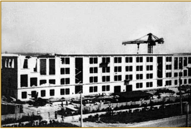
Будівництво першого корпусу
