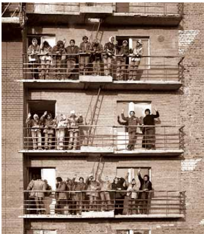
Студентський будівельний загін на будівництві гуртожитку № 4
