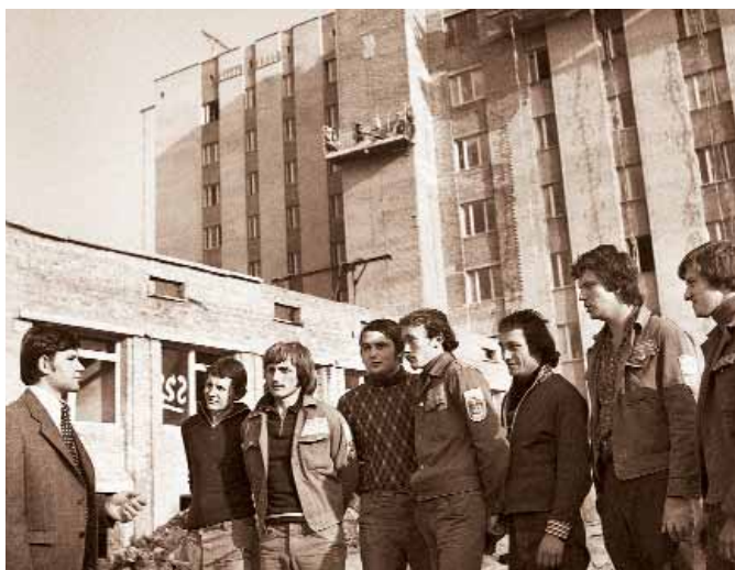
М. П. Войнаренко спілкується зі студентами будівельного загону на будівництві гуртожитку
