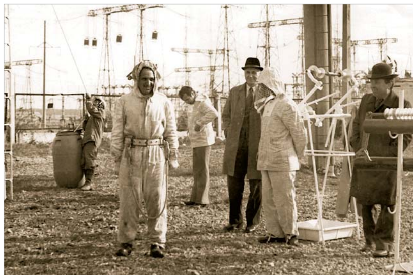
Підготовка до робіт на підстанції
