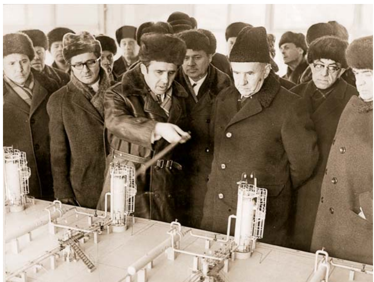
В. О. Швець і О. М. Косигін — на будівництві Оренбурзького нафтогазохімічного комплексу
