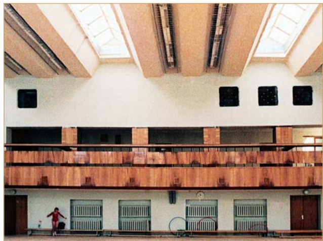
Покриття спортивного залу Центру творчості дітей та юнацтва Галичини виконане з пустотних складчастих настилів прольотом 18 м із трикутними світловими ліхтарями
