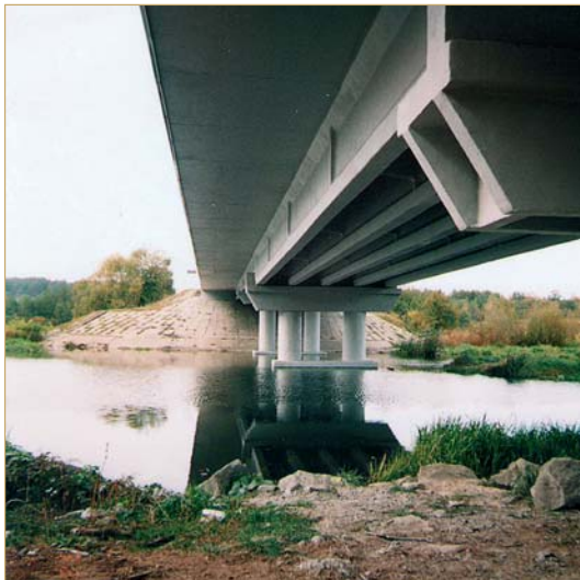
Лабораторні і натурні дослідження дозволили вперше в Україні підсилити композитами прольотні будови шляхопроводу в с. Вістова Івано-Франківської обл. та мосту через р. Уж на 149 км автомобільної дороги Київ–Ковель–Ягодин Житомирської обл.
