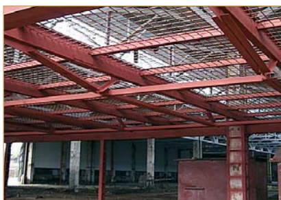
Ефективні малоелементні форми перекриття, які мають до 27% меншу масу порівняно з типовими конструкціями (автори М. В. Гоголь, к. т. н., доц. М. Р. Більський)
