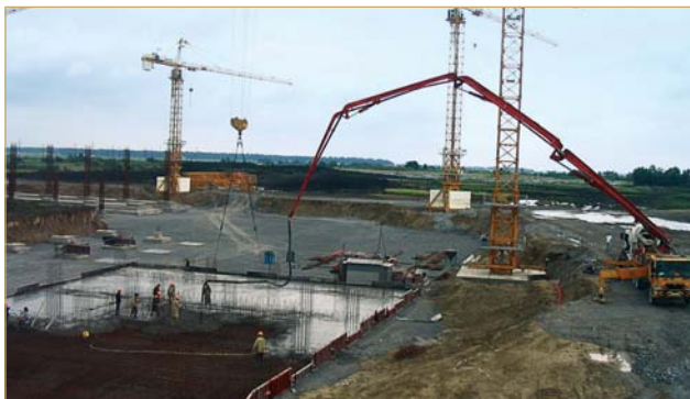
Контроль якості високофункціонального бетону при будівництві стадіону в м. Львові
