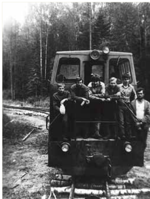
У студентському загоні під час прокладання вузькоколійної залізниці, 1985 р.
