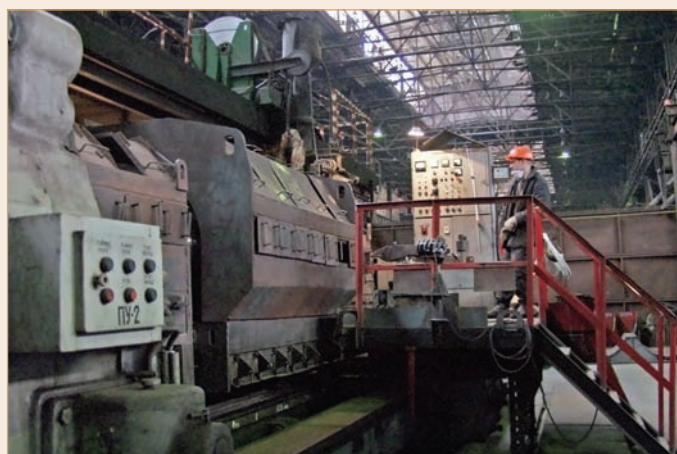
Производственный участок износостойкой наплавки прокатных валков, при создании которого использованы разработки ученых ПГТУ
