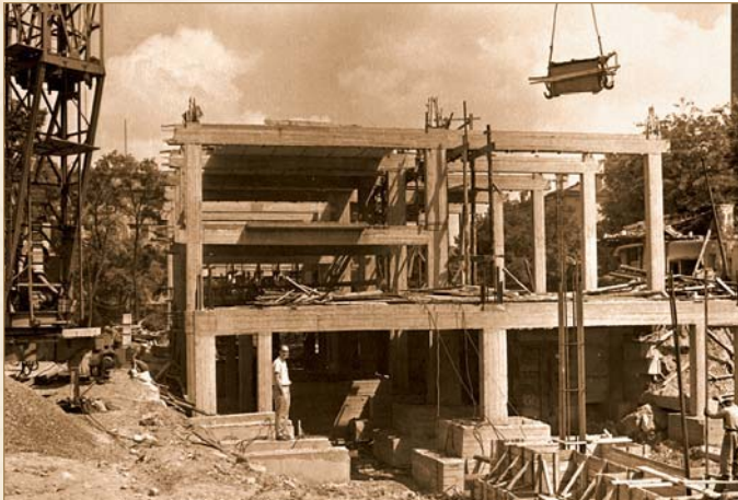
Строительство учебного корпуса
