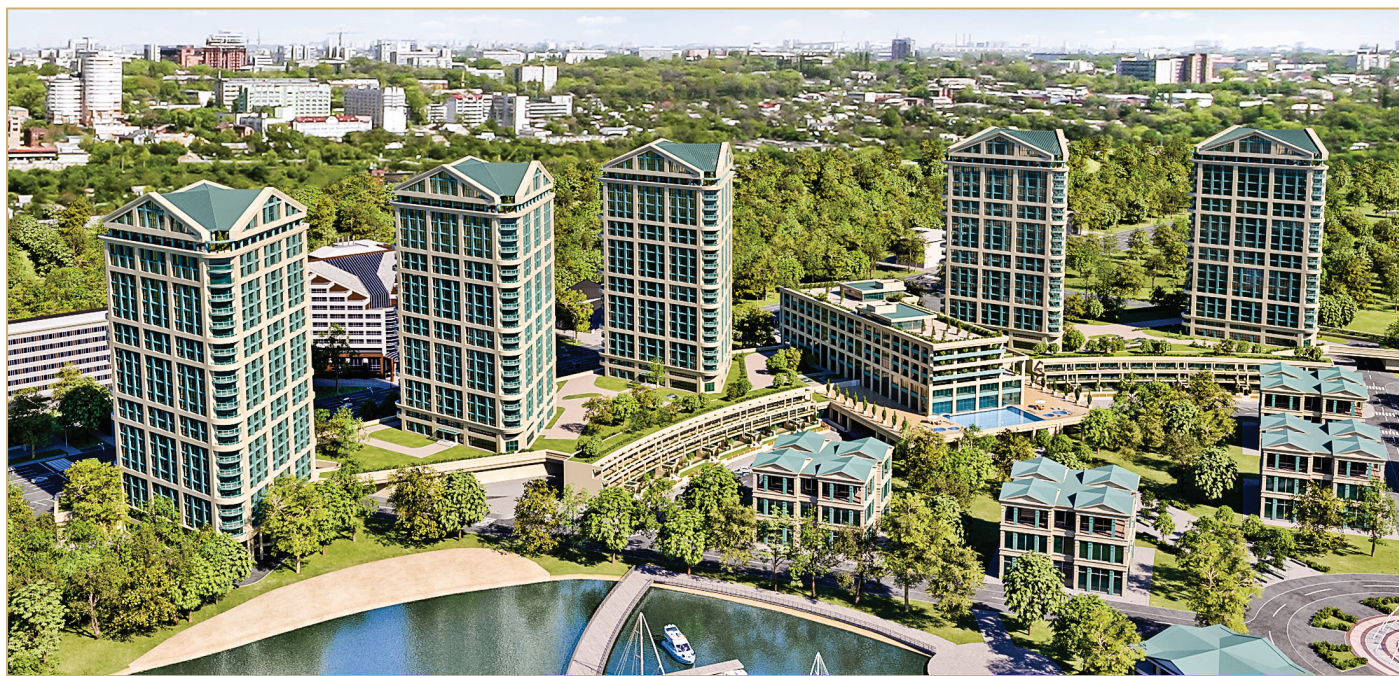
Багатофункціональний комплекс «River Town» на вул. Набережній Перемоги в районі буд. 9б, м. Дніпро
