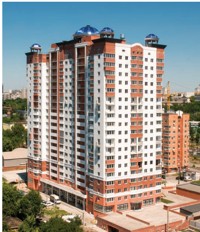
Житловий будинок на вул. Сухумській
